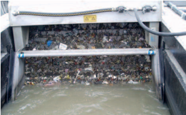
HUBER Stufenrechen STEP SCREEN® SSF: Länge 3.500, Breite 1826, Spaltweite 6 mm, Aufstellwinkel 50°. Durch die einmalige Durchströmung der Siebfläche sind sehr große Durchflussmengen realisierbar.
