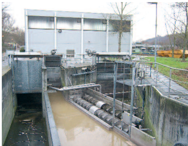
Kombination verschiedener Rechensysteme zur optimalen Behandlung großer Abwassermengen
