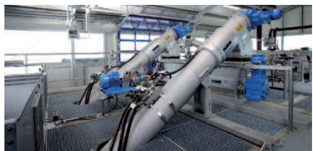
HUBER Membrane Screen ROTAMAT® RoMem zur Steigerung der Betriebssicherheit von Membran-Belebungsanlagen
