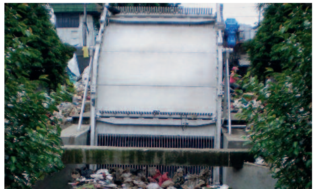
Robuste Rechentechnik für die Grobstoffentnahme mit großer Aufnahmekapazität der Rechenharken
