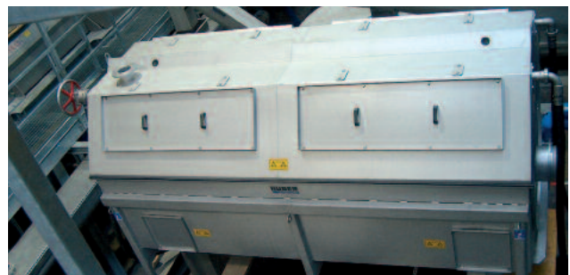
HUBER Trommelsieb RoMesh® mit einer Maschenweite von 0,5 mm zur Aufbereitung von Spülwasser
