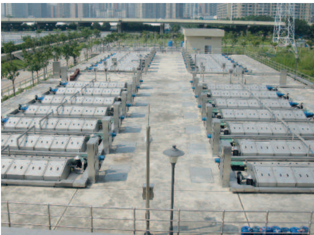
28 HUBER Scheibenfilter RoDisc® mit jeweils 24 Scheiben reinigen knapp 8,5 m³ Abwasser pro Sekunde
