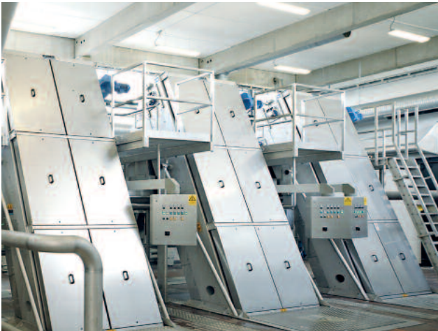
HUBER Lochblech-Umlaufrechen EscaMax® – ein vielseitig einsetzbarer Zulaufrechen mit hoher Abscheideleistung
