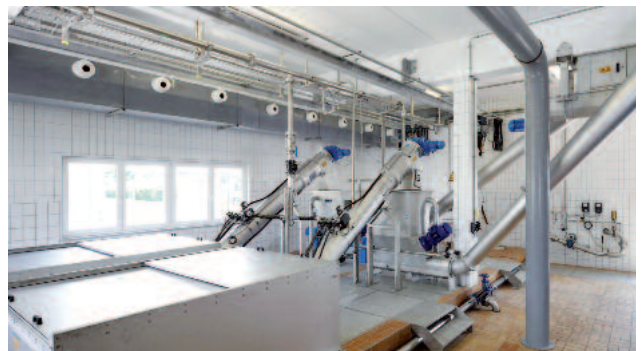
HUBER Siebanlagen ROTAMAT® Ro2 mit geschlossener Edelstahlabdeckung
