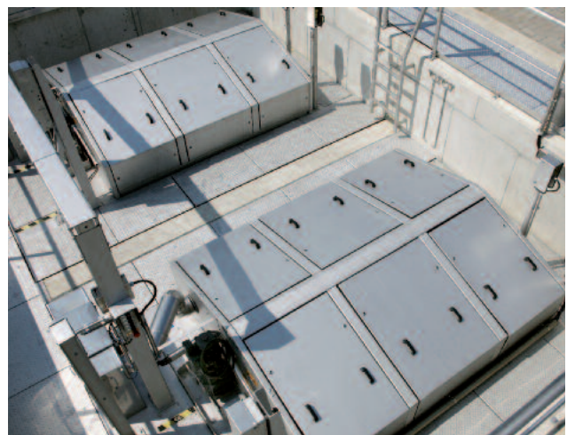
HUBER Scheibenfilter RoDisc® Scheibenfilter mit bis zu 35 Scheiben in einer Maschine,
