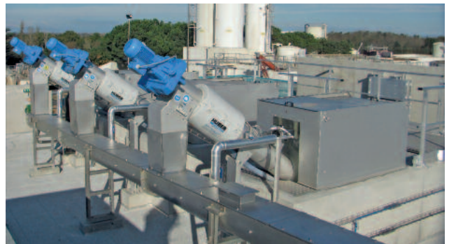
HUBER Siebanlage ROTAMAT® STAR mit 1 mm Lochdurchmesser zum Schutz nachgeschalteter Membrananlagen
