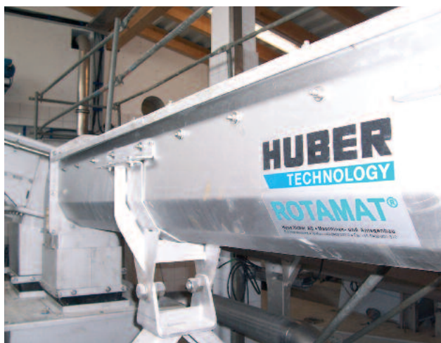
ROTAMAT® Transportschnecke Ro8/Ro8 T, einsetzbar für alle Arten des Rechenguttransportes
