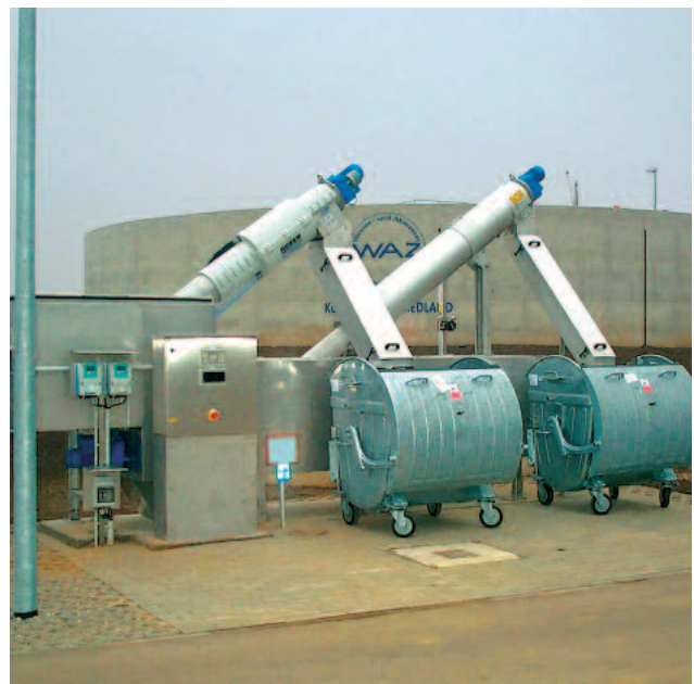
HUBER Fäkalannahmestation ROTAMAT® Ro 3.3 als Kompaktanlage mit Sandfang und Sandklassierer
