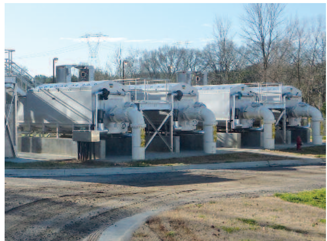
4 HUBER Scheibenfilter RoDisc® mit 18 Scheiben im Edelstahlbehälter
