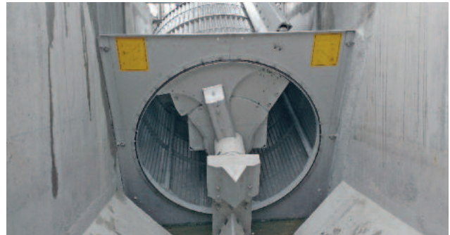
ROTAMAT® Membrane Screen liquid mit Siebgutaustrag mittels Pumpe
