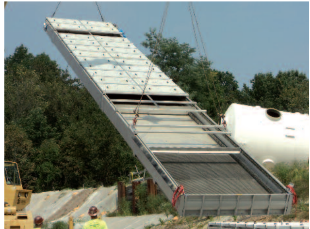
HUBER Harken-Umlaufrechen RakeMax® mit einer Länge von 23 m beim Einbau in eine Pumpstation
