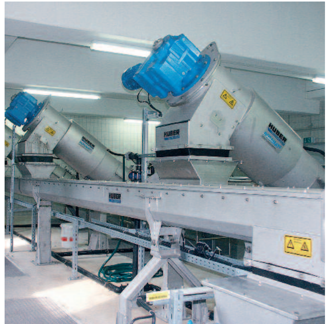
HUBER Membrane Screen ROTAMAT® RoMem vor einer Hohlfasermembrananlage
