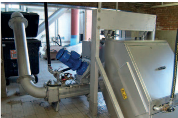
HUBER Stufenrechen STEP SCREEN® SSF in Kombination mit der HUBER Waschpresse WAP® SL für eine intensive Rechengutauswaschung in komplett geruchsgekapselter Ausführung.
