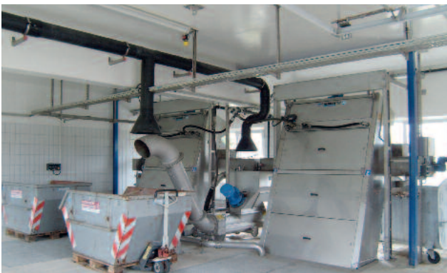
Zwei HUBER Stufenrechen STEP SCREEN® SSV, Länge 4300, Breite 1676, Spaltweite 6 mm, in Kombination mit der HUBER Rechengut-waschpresse der Baureihe SL für eine intensive Rechengutauswaschung in komplett geruchsgekapselter Ausführung.
