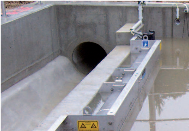
HUBER Siebanlage ROTAMAT® RoK2 vor dem Entlastungsbeginn
