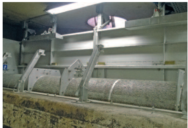
HUBER Siebanlage ROTAMAT® RoK 2 - Optionale Ausführung mit Notentlastungsklappe
