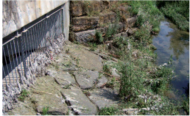
Typisches Bild eines Regenauslassbauwerkes ohne Grobstoffrückhalt nach einem Entlastungsereignis
