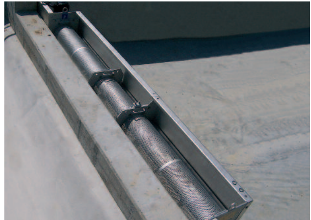
HUBER Siebanlage ROTAMAT® RoK2 nach erfolgter Montage
