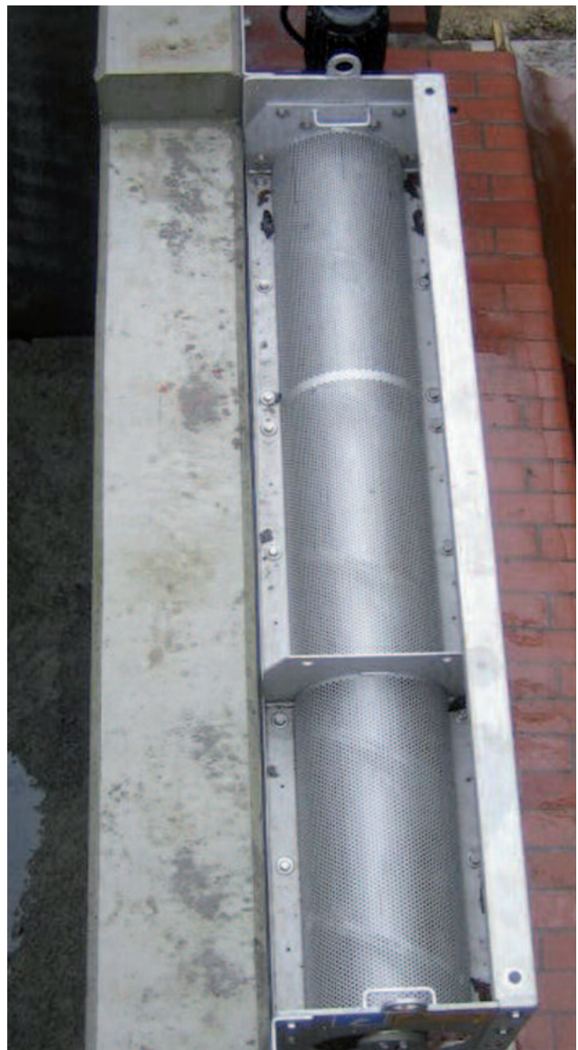
Einsatz einer HUBER Siebanlage ROTAMAT® RoK2 in einem Entlastungsbauwerk
